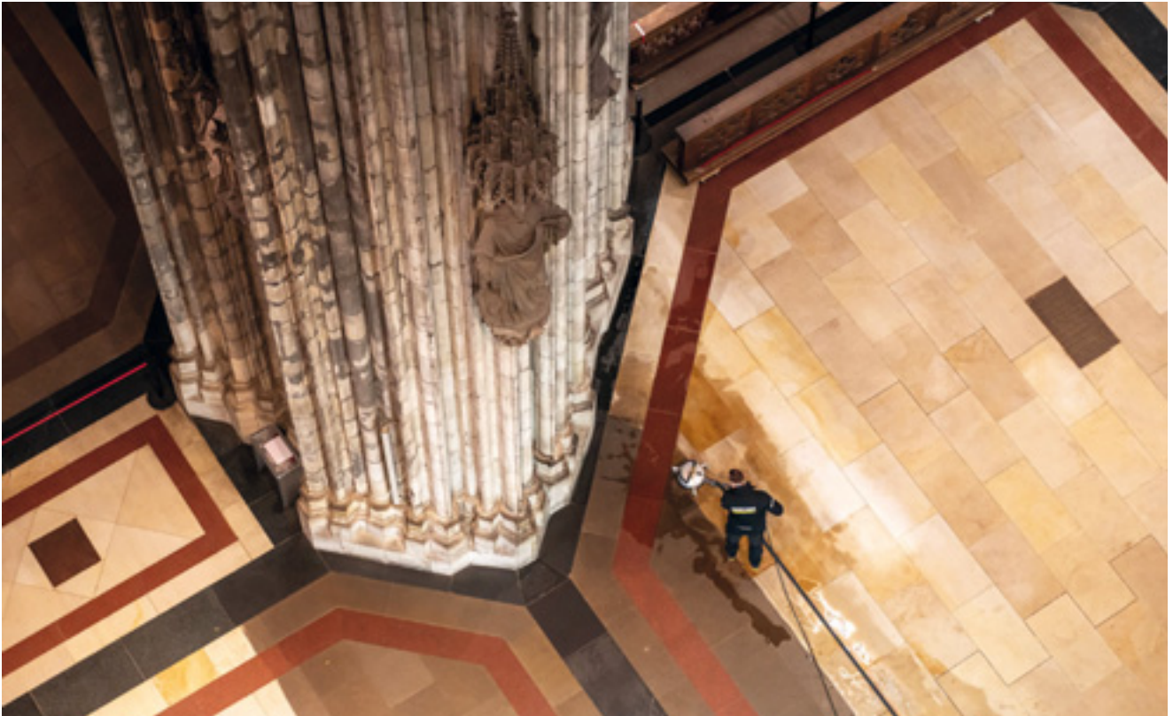
Mithilfe eines Heißwasser-Hochdruckreinigers und eines Flächenreinigers bearbeiteten Mitarbeiter des Geräteherstellers und der Dombauhütte 4.000 m 2 Sandsteinboden, um den Schmutz aus den Poren zu lösen. Foto: Alfred Kärcher
