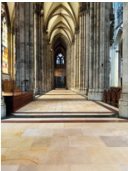
Der gereinigte Belag im Langhaus des Kölner Doms Fotos: Bärbel Holländer
