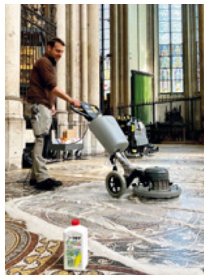
Die Wachs- und Pflegemittelschicht wurde mit dem mild alkalischen »HMK R157 Fliesen-Intensivreiniger« entfernt, im Bild Jasper Völkert von der Dombauhütte Fotos: Bärbel Holländer
