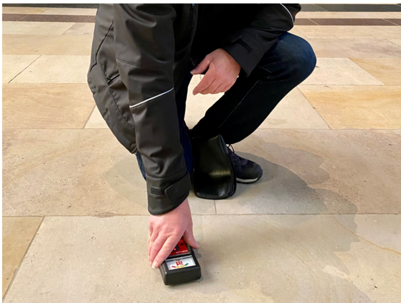
Feuchtigkeitsbestimmung zur Klärung des weiteren Vorgehens.
